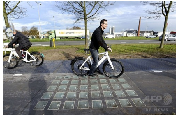
図 3 1 オランダ・クロメニーの自動車専用道路に埋め込まれた太陽電池モジュール (2014年11月12日、 http://www.afpbb.com/articles/-/3031665 )
